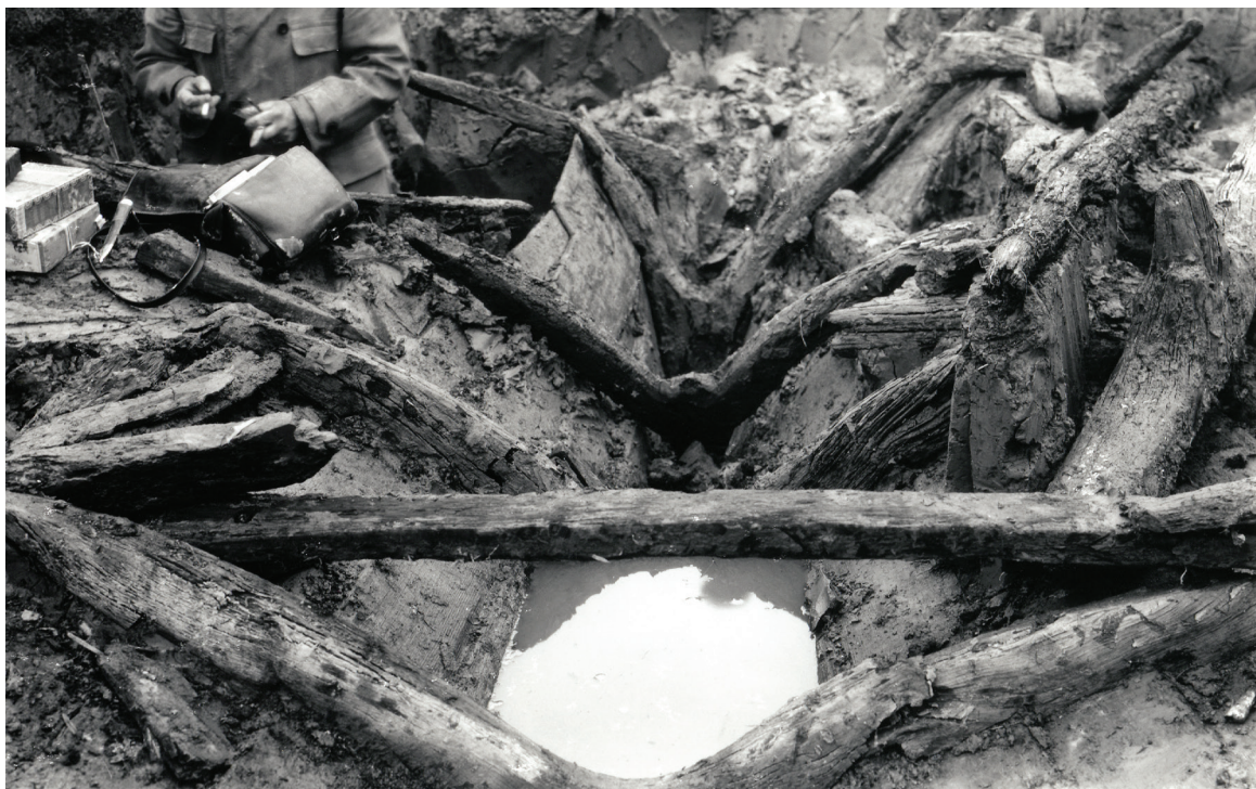
V-formade bottenstockar (spant) i fören. Till vänster ett av de sk hakborden. Längst till höger den tvärså med vinkelväxt gren, som utgör förtöjningsbalk i stäven. Foto: Stadsmuseet i Göteborg.
