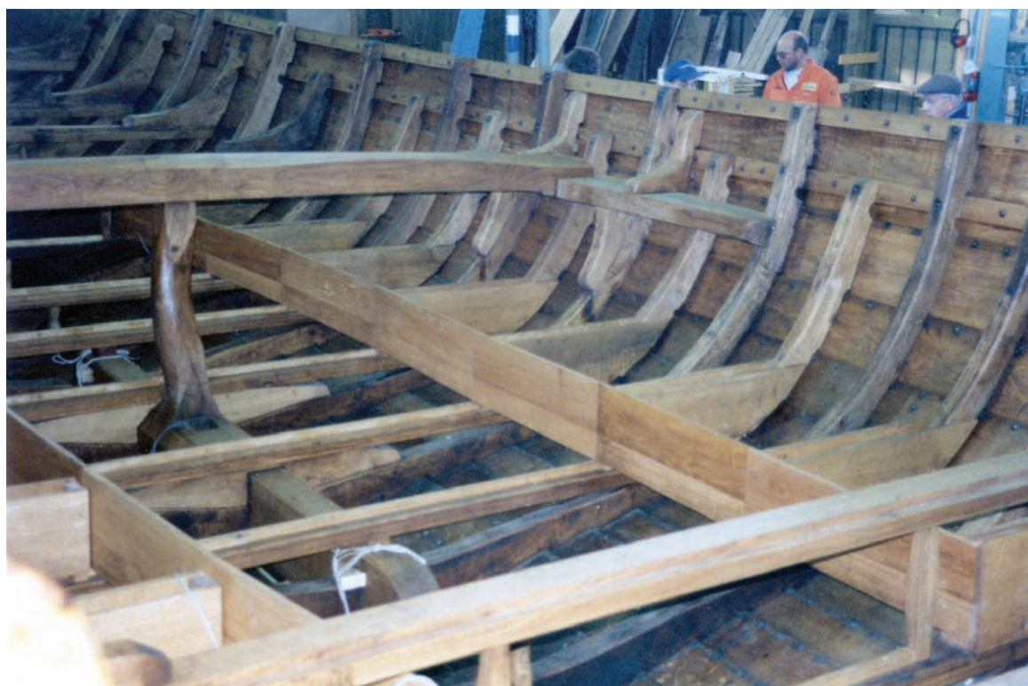
Mastfoten sträcker sig över fyra bottenstockar och är nerfälld över dessa. Vid nr 8 och 9 låst med överfall. En växt gren från mastfoten går upp i den tvärsöver skeppet liggande mastbalken. Utefter sidorna syns de blivande barlastlådorna. Foto: SVS.
