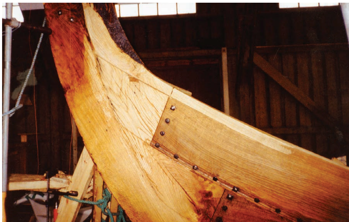
Infästningen av det översta hakbordet. Landningen för bord nr 7, som ska nå spunningslinjen i stäven, är utmejslad.
